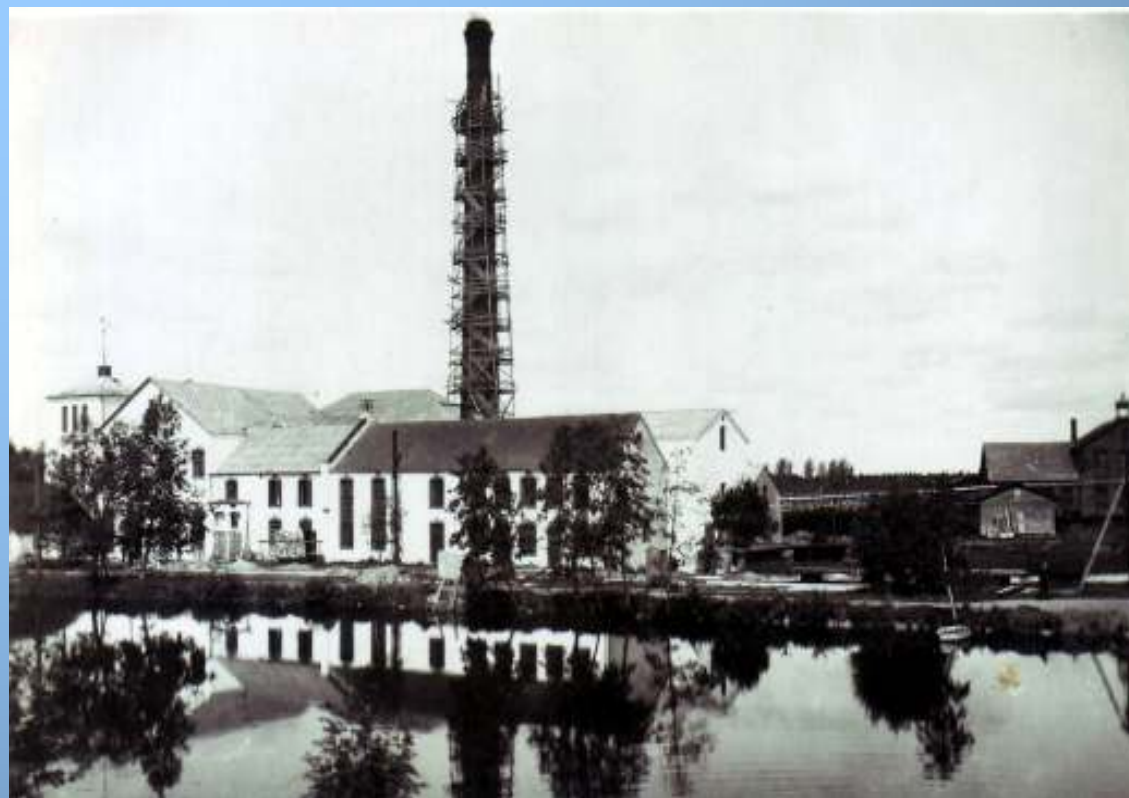
Kohila paberivabriku uue korstna ehitus 1910
